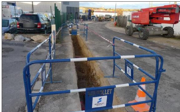
La tranchée creusée à l'intérieur de la zone d'activités de Beauregard est destinée à recevoir la ligne à 20 000 volts qui alimentera les entreprises. Photo LBP/D. G.
