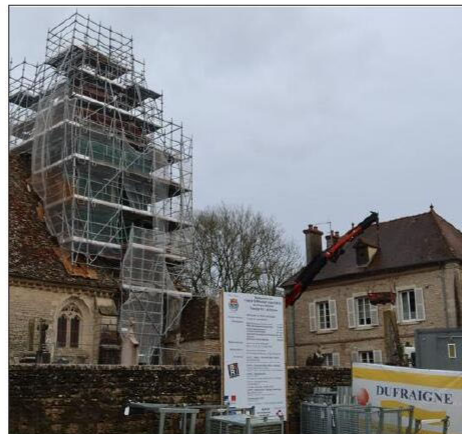
La charpente du clocher de l'église a été restaurée, les tuiles sont en cours de pose. Photo LBP/G.L.
