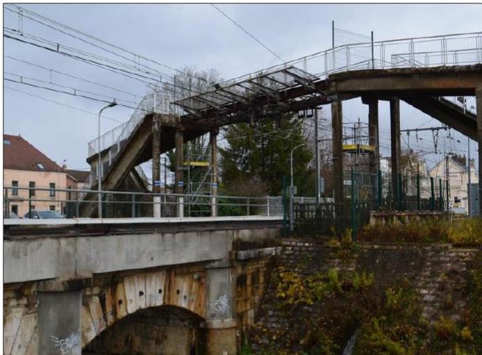
En décembre dernier, le tablier de la passerelle SNCF a été démantelé. La déconstruction totale de l'ouvrage devrait avoir lieu à l'automne 2022 et plusieurs scénarios sont déjà envisagés pour la remplacer. Photo LBP/Patrick PREVOST
