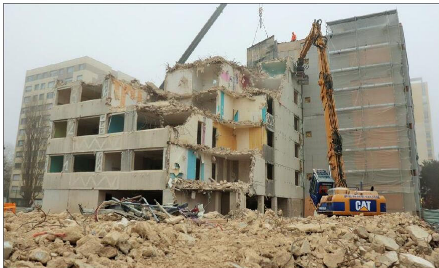
Les pelles de l'entreprise Pennequin procèdent au grignotage des derniers étages de la tour 32. Une opération délicate, car le bâtiment est mitoyen d'un autre immeuble où vivent des habitants. Photo LBP/N. D.
