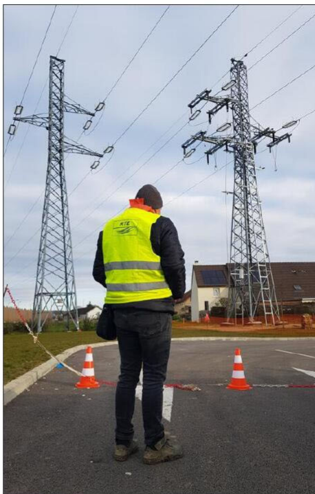
Un pylône situé sur le parking du Bricocash a été renforcé et modifié pour accueillir la liaison souterraine. Photo LBP/T. S.
