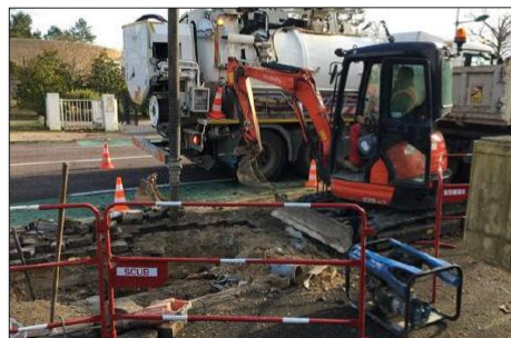
Après une journée continue de recherches, la fuite a pu être réparée sur la conduite principale d'approvisionnement en eau.
