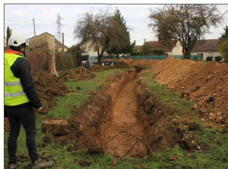
Une liaison souterraine est en train d'être construite. Elle se situe entre les pylônes aérosouterrains en cours d'installation au Camp américain et celui du Bricocash. Photo LBP/T. S.
