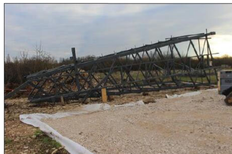
Les deux pylônes aérosouterrains entre le Camp américain et l'A6 ont été assemblés au sol. Photo LBP/T. S.
