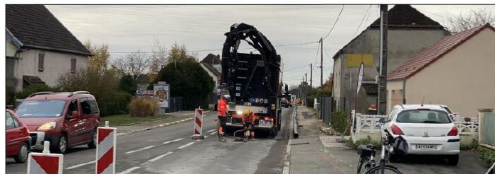
Une machine qui permet d'avancer plus vite et un nombre d'ouvriers plus important doivent permettre au chantier de durer 3 semaines au lieu de 4 mois. Photo Progrès/Michel MARILLY
