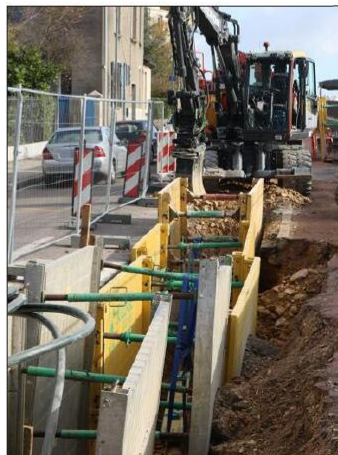
Des tranchées sont creusées pour créer 750 mètres d'extension du réseau de chaleur. Photo LBP/A.-F. B.
