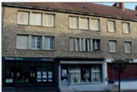
Une aide à la rénovation de façades a été votée pour un immeuble situé rue Maréchal-de-Lattre-de-Tassigny. Photo (AP) A.G.
