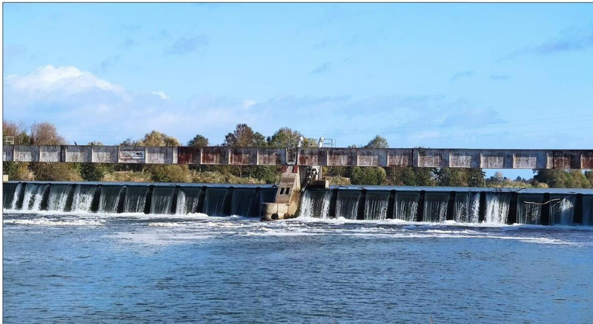
Le barrage de navigation de Pagny est un ouvrage à vannes clapets, composé de trois passes de 35 m de large, pour une largeur totale de l'ordre de 117 m.
