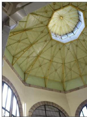
La coupole de la maison d'arrêt de Dijon, avec ses armatures métalliques. Photo LBP/A.-F. B.
