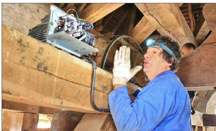
Le campaniste le plus expérimenté explique le fonctionnement du moteur qui commande l'oscillation de la cloche Louise-Joséphine. Photo LBP/M. D.
