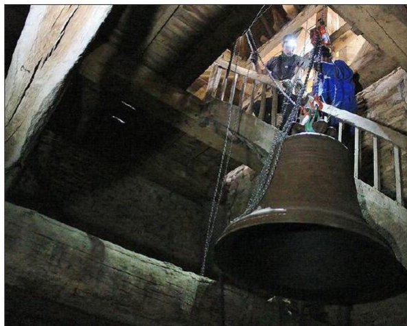
Grâce à des palans fixés en hauteur sur la charpente du clocher de l'église, les deux hommes montent plutôt rapidement la belle bête de bronze, qui pèse 812 kilogrammes. Photo LBP/M. D.
