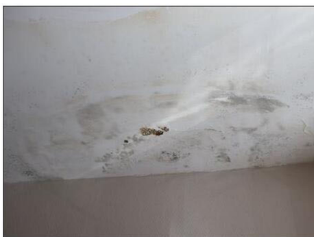
La fuite d'eau qui s'est manifestée cause des dégâts sur le plafond. Photo LBP/F. S.
