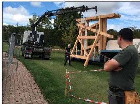
« C'est une charpente à une seule pente, dont l'alignement ne suivra pas la courbe au sol. Elle est réalisée en lamellé-collé de douglas pour une structure de grande longévité », expliquait le trio d'experts dépêché sur place pour le montage. Photo LBP/Jean-François DUMAND
