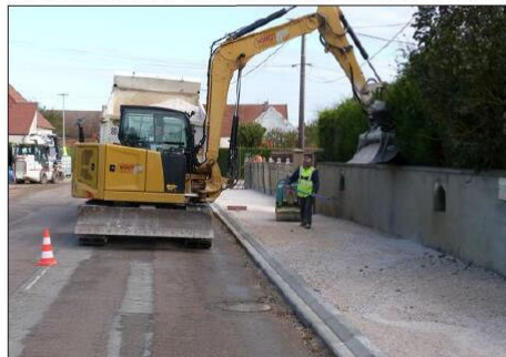
La mise en place de bordures de trottoirs sur la route de Saint-Jean-de-Losne. Photo LBP/B. T.
