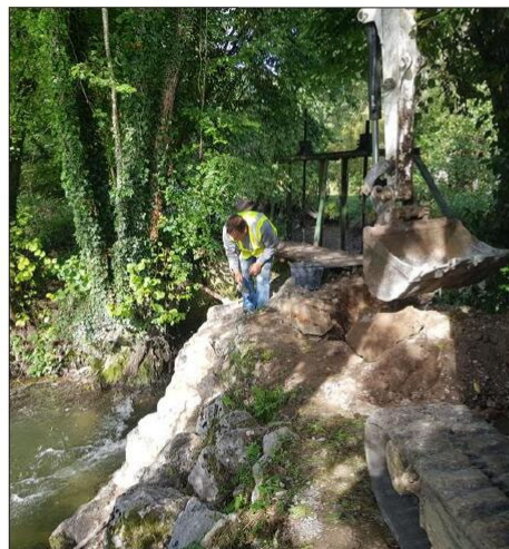
Les travaux, réalisés par l'entreprise Chenot de Gerland, ont permis de conforter l'ouvrage qui « était prêt à s'effondrer, notamment à cause de nombreuses infiltrations d'eau », expliquent les membres du syndicat du bassin versant de la Dheune. Photo LBP/Ch. D.
