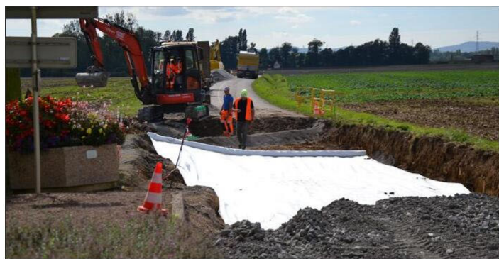
Un décaissement de 80 cm de profondeur a été nécessaire. Photo LBP/J.-P. L.
