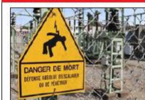
Le poste du Petit-Bernard convertit l'électricité qui arrive par RTE en haute tension à 63 000 volts en 20 000 volts, distribués par Enedis. Photo LBP/A.-F. B.
